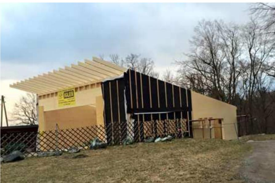
Nach dem die Bodenplatte betoniert wurde, werden nun die Fertigelemente der Bühne aufgestellt. Innerhalb weniger Tage stehen alle Wände der Proberäume, in Kürze wird auch das Dach fertig sein.
