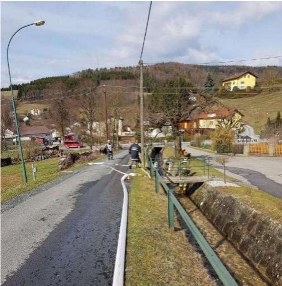
Es wurde eine Zubringerleitung vom Stubenbach dem Graben hinauf, bis Höhe Puhr Gerhard, hergestellt. Dieser Test brachte uns einige Erkenntnisse zur neuen Tragkraftspritze. Die Erkenntnisse haben wir bereits mit der Firma Rosenbauer besprochen und können diese nun bei zukünftigen Einsätzen einfließen lassen.
