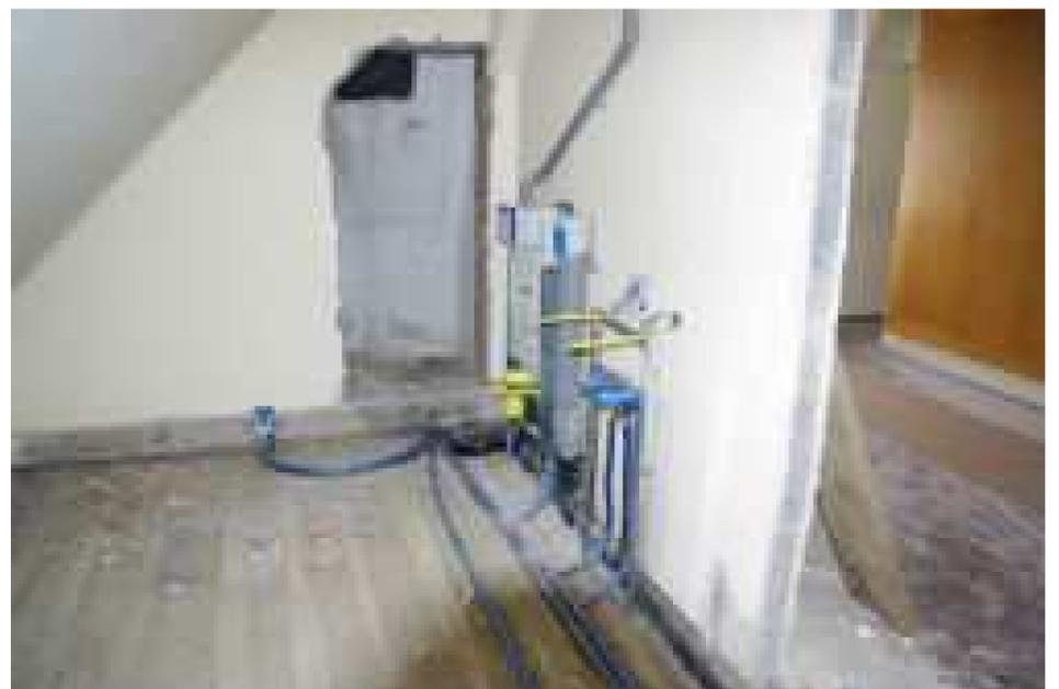
Nicht mehr benötigte Durchgänge (mit Türen) wurden bereits mit Gipskartonplatten geschlossen, so manche Wand als Begrenzung für den sanitären Bereich muss noch aufgestellt werden.
